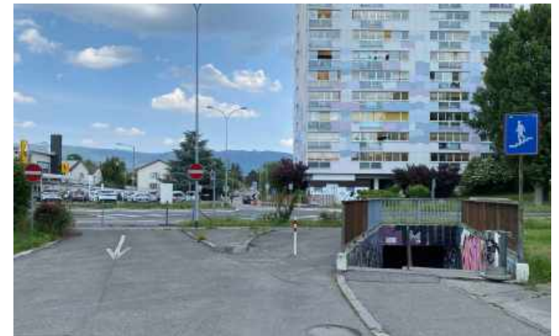
Freiraumzäsuren entlang Bernstrasse (4)
