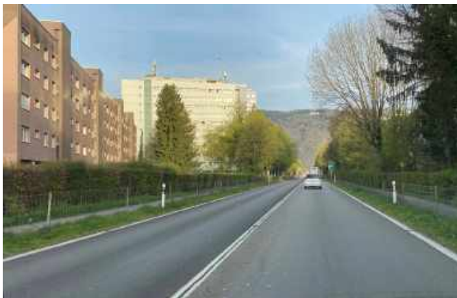
Bernstrasse Höhe Schindlerhöhe (4)
