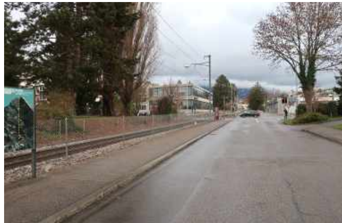
Keltenstrasse, räumliche Trennung Bahnlinie (2)
