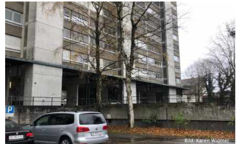
Typisches Erdgeschoss mit Aussenraum, Bielstrasse 18-22 (4)
