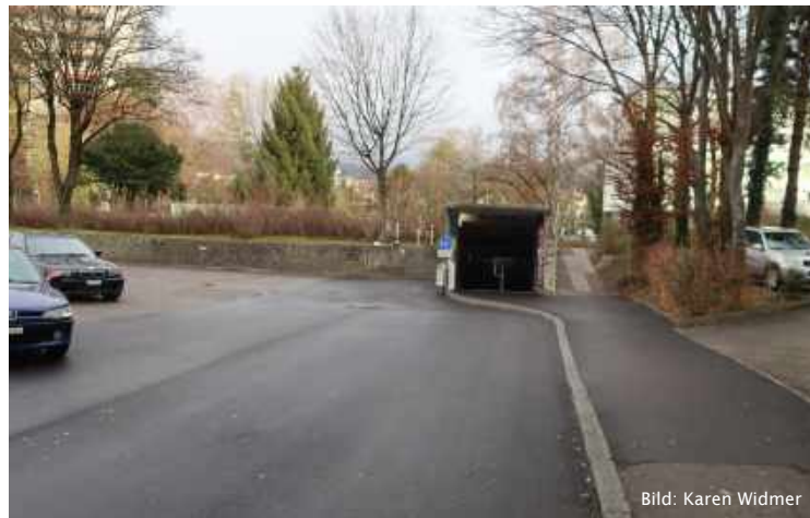
Bernstrasse Auswirkung räumliche Trennung (3)
