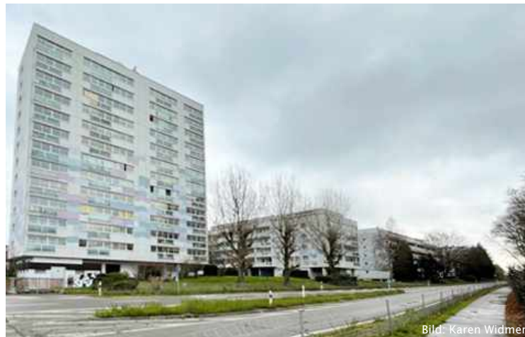
Hochhaus Kreuzung Bernstrasse - Guglerstrasse (3)
