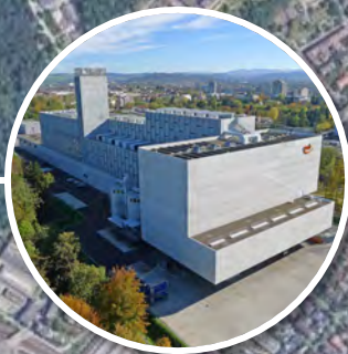
Energiezentrale Forsthaus (EZF)
