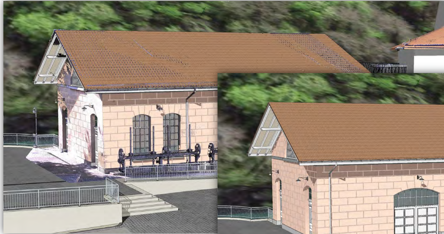
Maschinenhaus des Kraftwerk «Matte» heute
