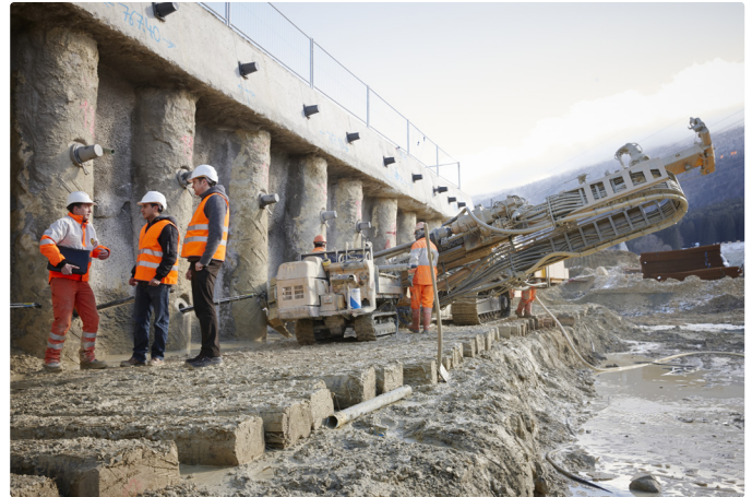
Fondations sur pilotis d'un site de construction de Marti AG, Transjurane
