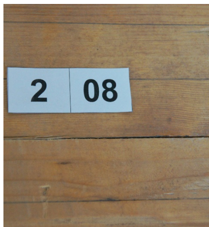
Abb. 9: Delaminierung in der Klebefuge
