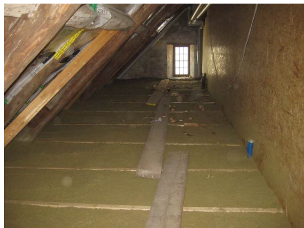
Abb. 15: Ausgedämmter Bodenhohlraum
