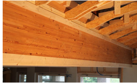
Abb. 4: Überprüfung der Leistungsfähigkeit durch Versuche mit Bauteilen im Masstab 1:1 an der EMPA Dübendorf und anschliessender Anwendung in einem zu sanierenden Dachtragwerk.
