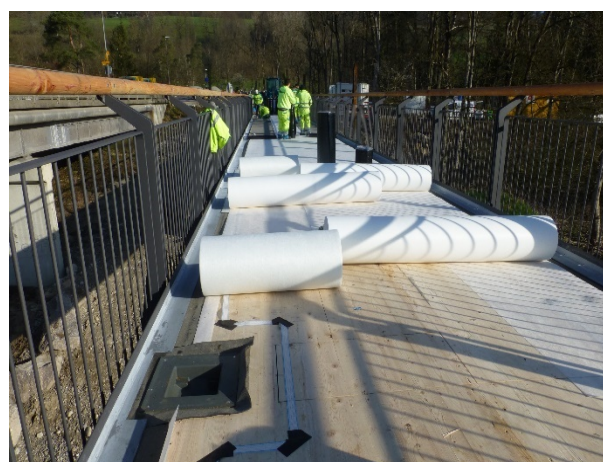
Abb. 9: Bandsensor «dm» der Firma ProGeo in einem Warmdachaufbau (links) und Detail (rechts)
