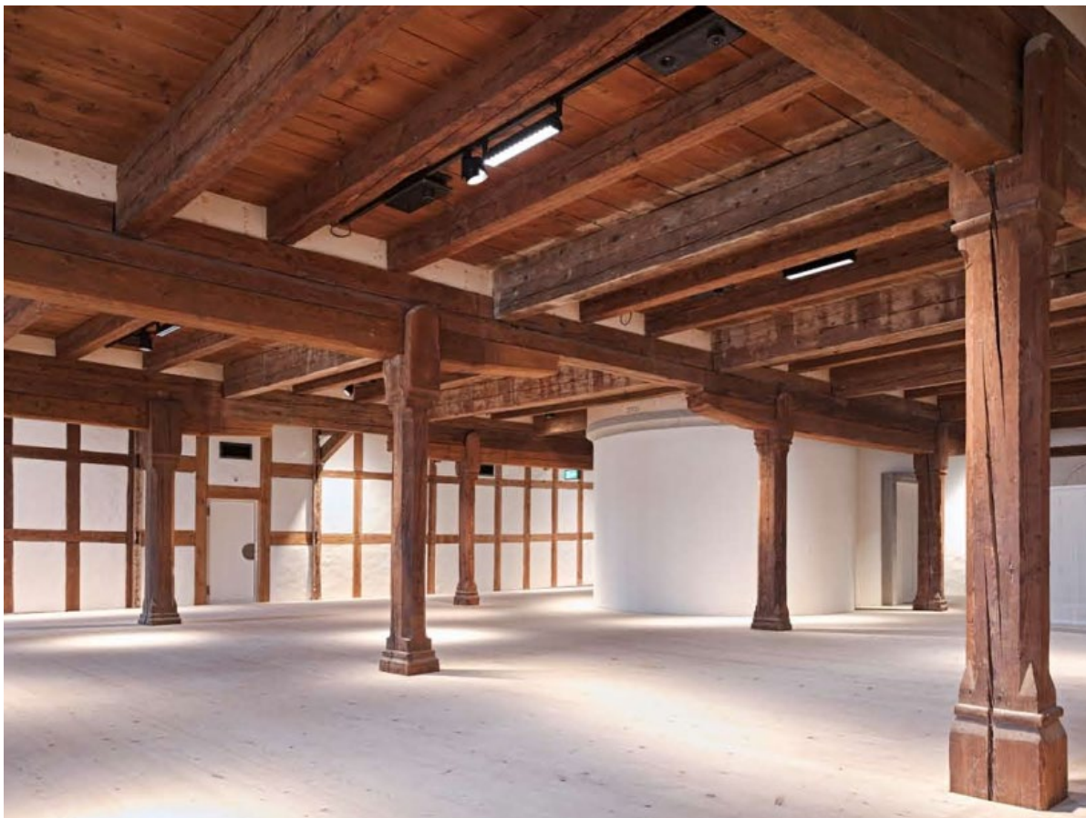
Abb. 20: 3. OG: Sonderausstellungsgeschoss nach Umbau – Ertüchtigte Unterzüge, neuer Treppenturm
