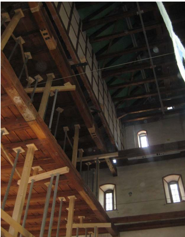
Abb. 12: Abfangung Riegelwand 4. OG
