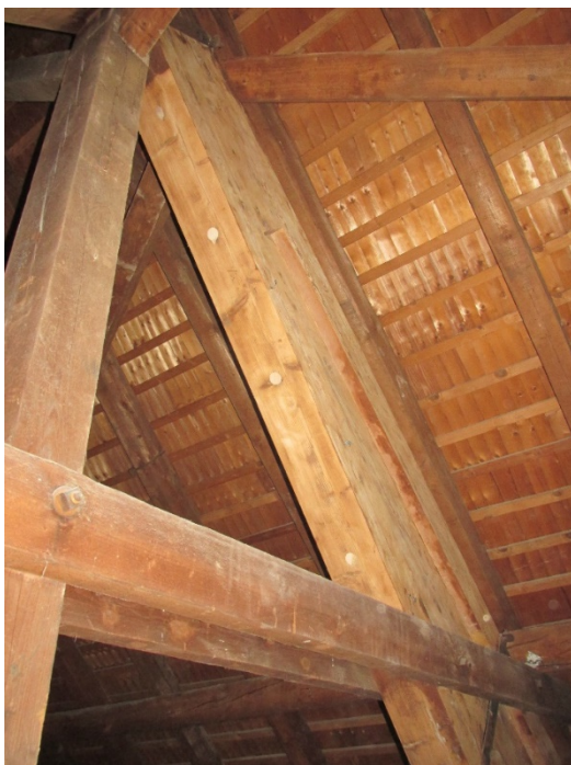
Abb. 13: Sanierter Träger im oberen Bereich
