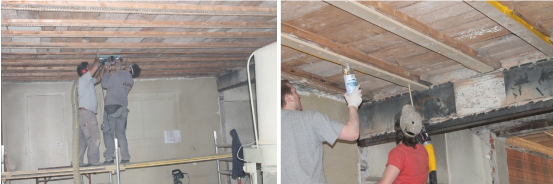
Abb. 8: Durchführung der Verstärkungsmassnahme
