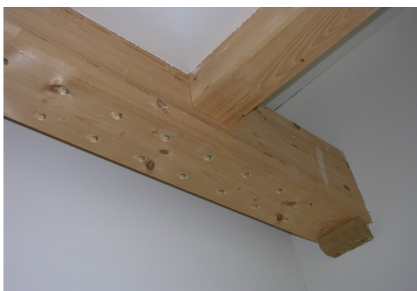
Abb. 7: Pfette mit diagonal eingedrehten Vollgewindeschrauben als Schubverstärkung
