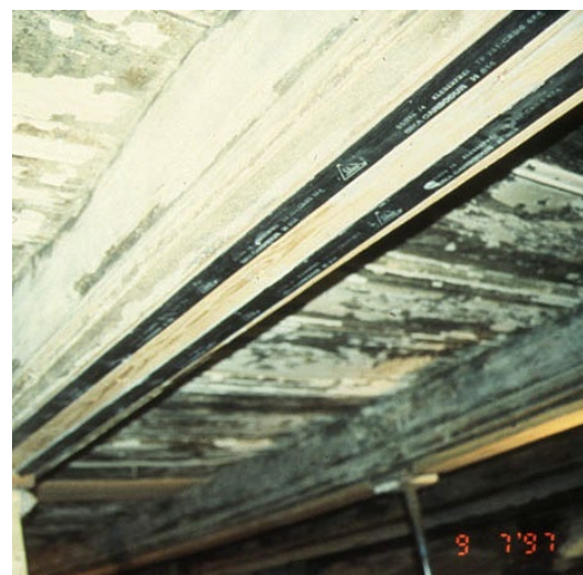
Abb. 5: Verstärkung Schönhof Görlitz
