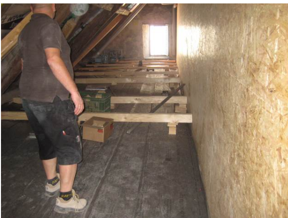
Abb. 14: Schiftung Boden im Technikraum
