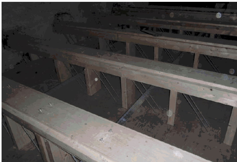
Abb. 3: Vergrößerung der statischen Höhe durch Ausbildung eines Fachwerks. Konzept: Aleksis Dind, Lutz Architectes Sàrl, Martin Geiser Conception Bois Sàrl
