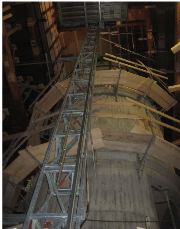
Abb. 13: Treppenhausöffnung bis Dach
