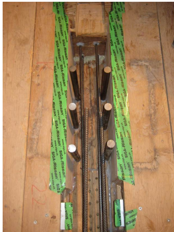
Abb. 17: Treppenhausöffnung bis Dach
