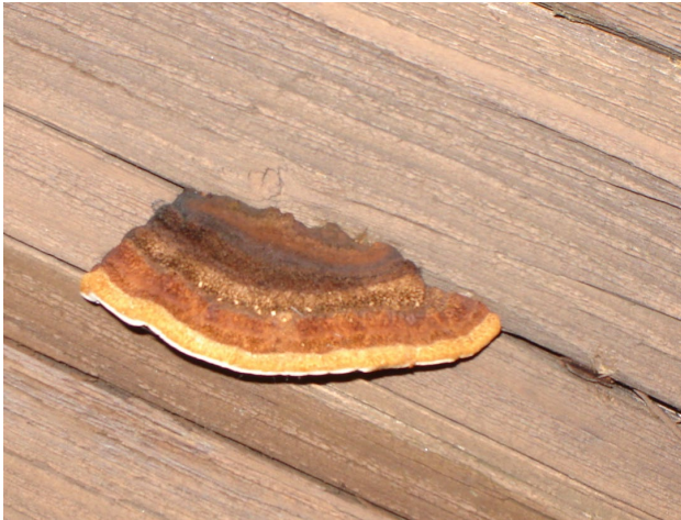
Abb. 12: Pilzbefall aufgrund zu hoher Holzfeuchte, Blättling Abb. 13: Schadensbild eines Hausbockkäfers
