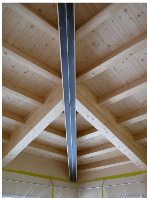
Abb. 8: Gratsparren mit schlaff aufgeklebten kohlenstofffaserverstärkten Kunststoffen
