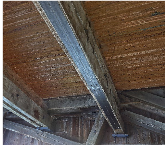
Abb. 2: Extern aufgeklebte CFK-Lamelle zur Biegeverstärkung (Holzbrücke in Sins)
