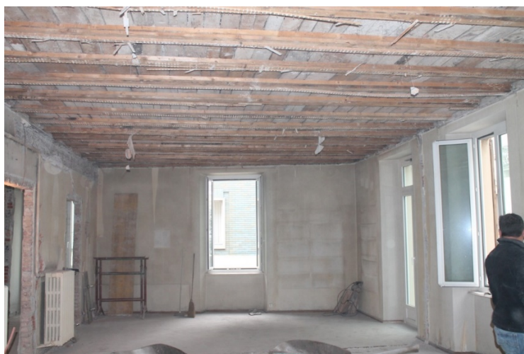
Abb. 6: Ansicht der bestehenden Balkenlage
