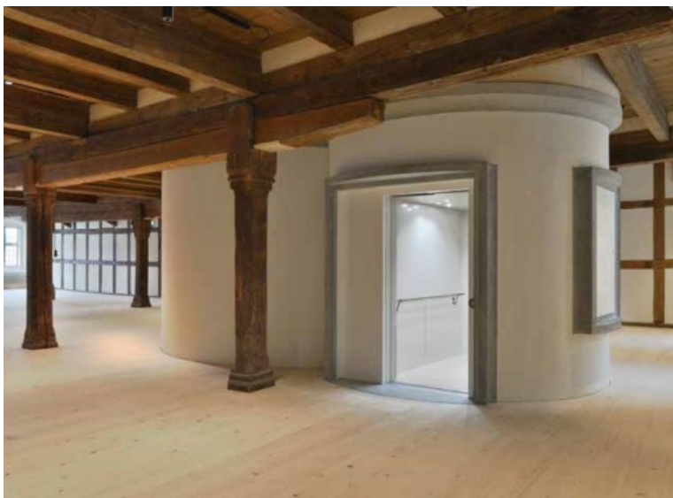
Abb. 2: Neuer Treppenturm und Liftanlage
