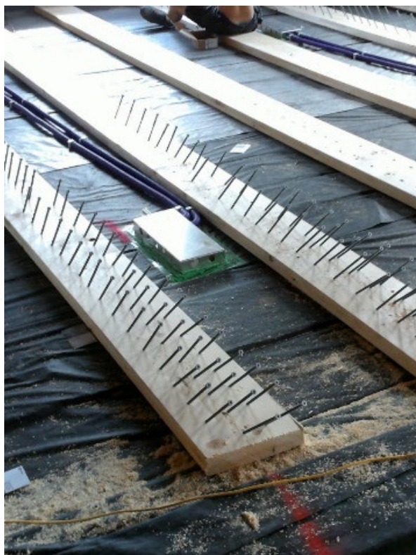
Abb. 18: Ertüchtigung Balkenlage
