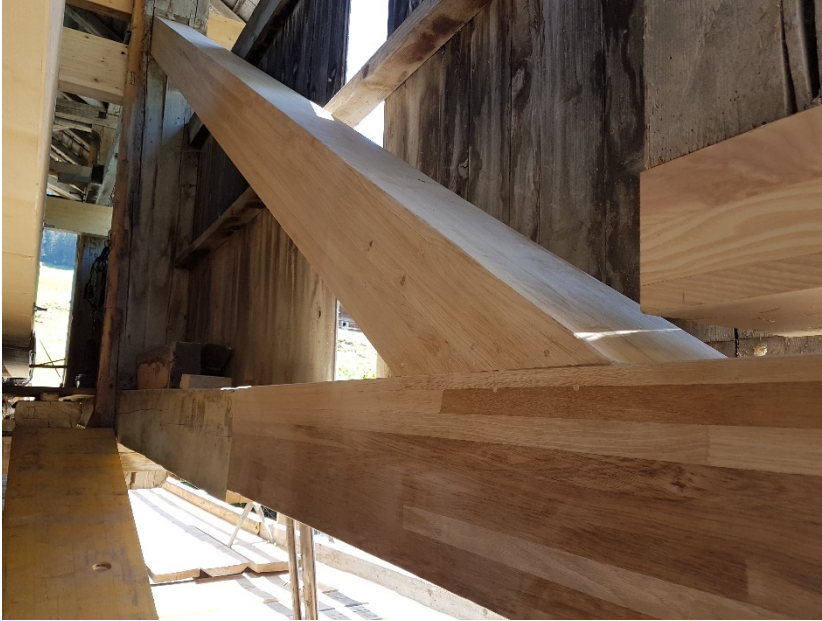
Abb. 14: Sanierung eines Brückenaufagers mit einer BSH Eichen Prothese
