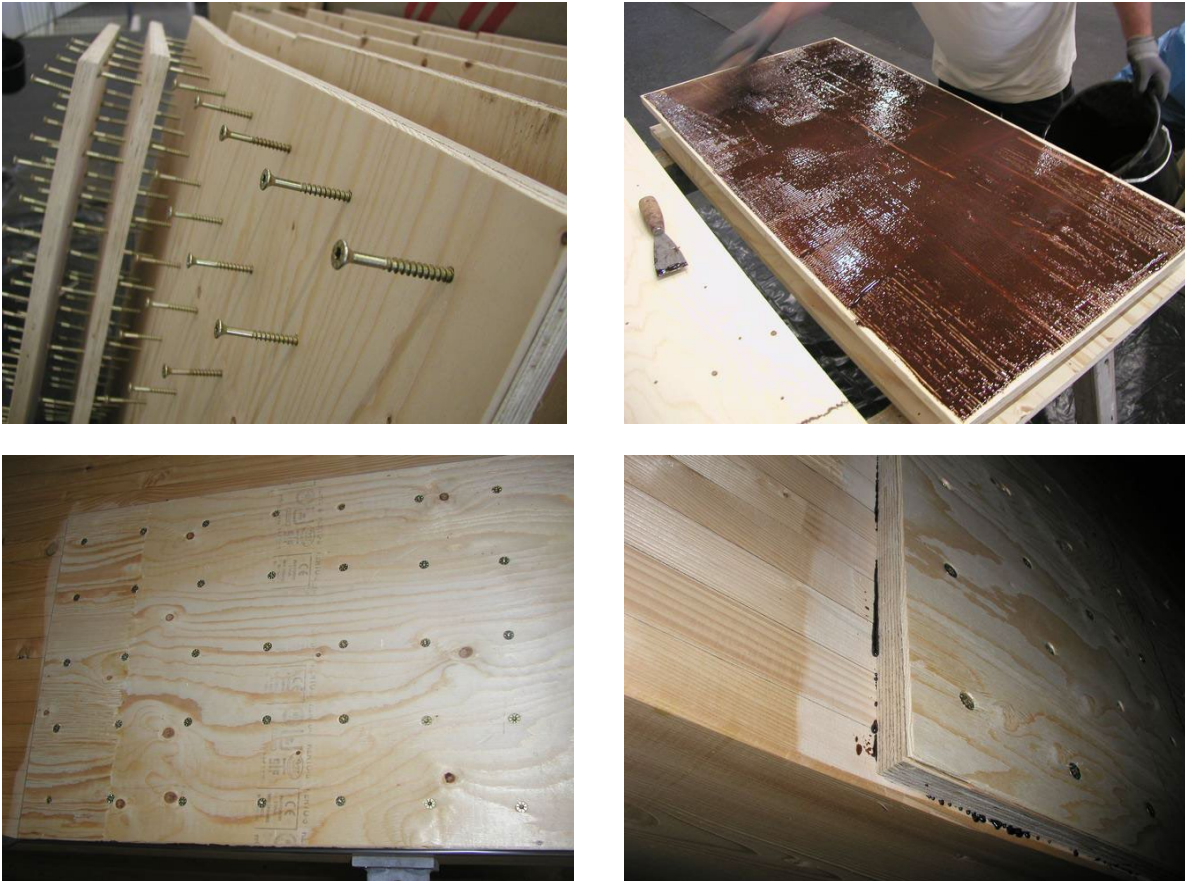
Abb. 6: Anwendung der Schraubpressklebung. Wichtige Parameter sind die erforderliche Anzahl Schrauben pro Fläche (links oben und unten), die Wahl, korrekte Menge und Verarbeitung eines nachweislich geeigneten Klebstoffs (oben rechts) sowie eine saubere und möglichst ebene Verklebungsfläche (unten rechts). Bilder: Holzforschung Austria
