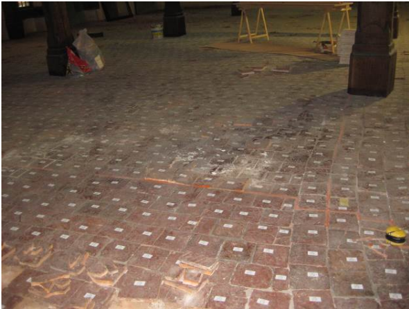
Abb. 10: Nummerierung Tonplatten vor Ausbau
