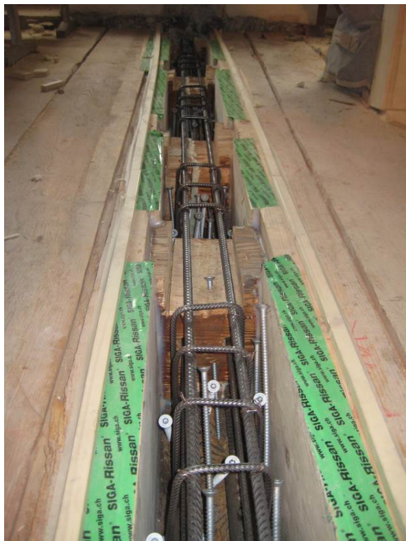
Abb. 16: UZ: Bewehrung und Schubverbinder
