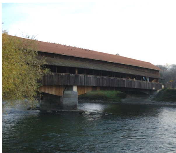
Abb. 4: Holzbrücke in Sins, Gesamtansicht
