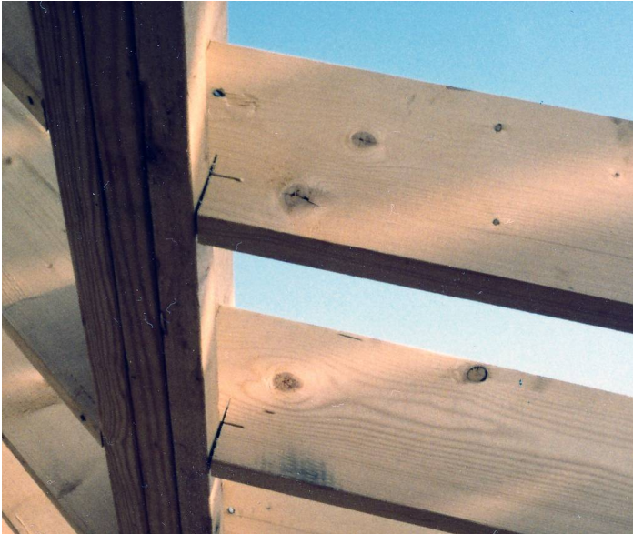
Abb. 4: Typische Ausklinkung
