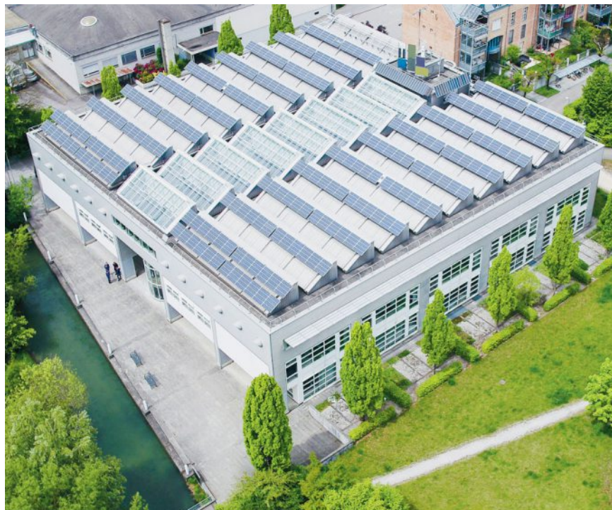
Installations solaires à la BFH à Berthoud LDD
