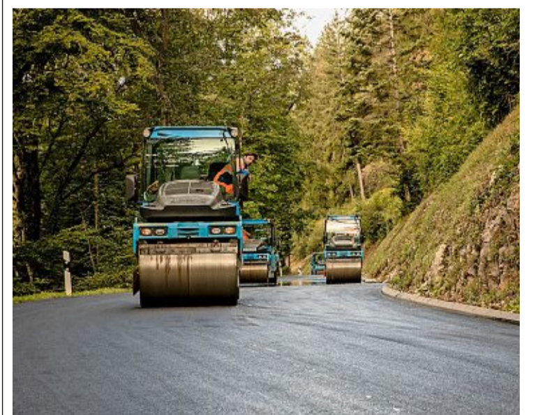
Die Kantonsstrasse wird mit «grünem Asphalt» saniert – mit Walzen, die sonst nur auf Autobahnen eingesetzt werden. Foto: Kostas Maros
