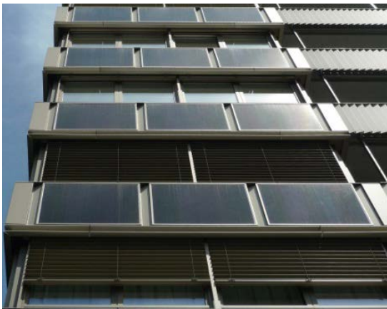
Photovoltaik-Fassadenintegration mit Standard- oder massgefertigten Solarmodulen am Beispiel Hochhaus Sihlweid (ZH) und einem MFH in Biel (BE)
