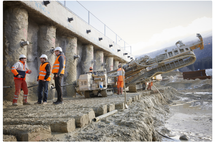
Pfahlfundationen auf einer Baustelle der Marti AG, Transjurane
