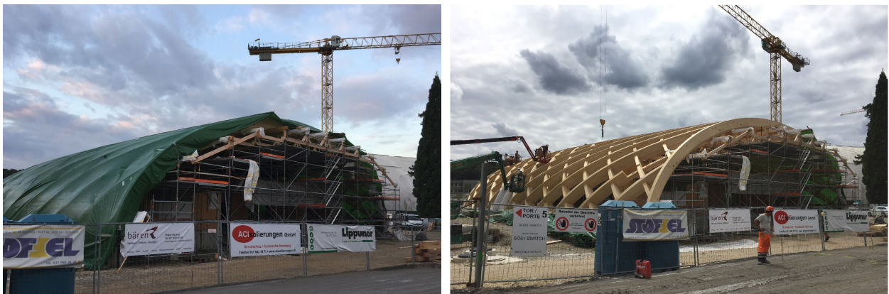
Abb. 17: Wirkungsvoller Schutz während der Bauruhezeit (nachts, Wochenende) oder bei direktem Regen, Öffnung der Abdeckungen während der tatsächlichen Bautätigkeit (Swatch Gebäude, Biel/Bienne)
