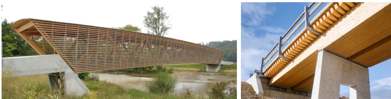
Abb. 16: Neumattbrücke mit Beplankung als konstruktiv geschützte Fachwerkbrücke (links), Überführung in Horen mit Witterungsschutz der Tragglieder durch ausreichenden Überstand (rechts)
