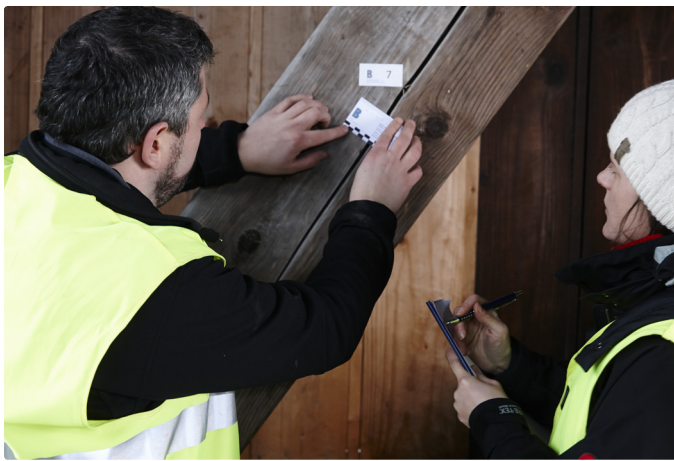
Mesure d'une fente du bois sur la structure d'un pont.
