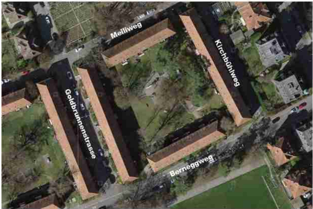
Abbildung 7: Orthofoto Goldbrunnenstrasse, Meiliweg, Berneggweg und Kirchbühlweg in Zürich. (Foto: swisstopo, 2022)
