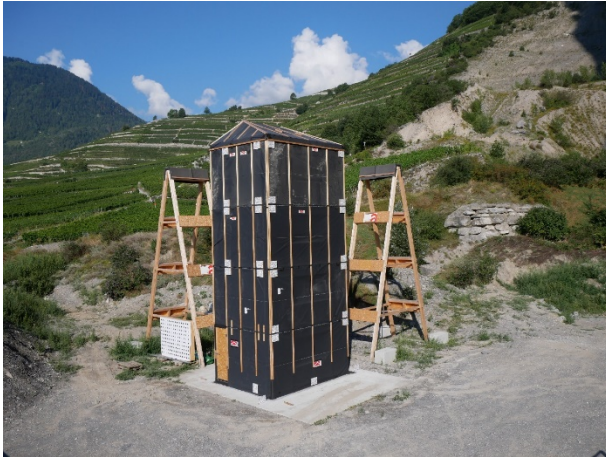
Légende 1 : Des essais dynamiques similaires, également sur un bâtiment en bois de quatre étages, ont été réalisés à Chamoson (Valais) en 2019 par la Haute école spécialisée bernoise.
