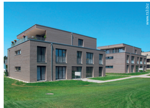
«Bauen mit Holz»: Als Leitobjekte zeigen die Mehrfamilienhäuser Holleracher zwischen Bern und Biel, was damit gemeint ist.
