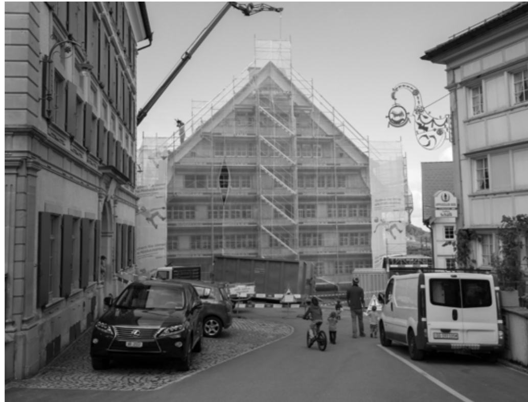
Die Alte Drogerie im Umbau Foto: Thomas Karrer, Trogen
