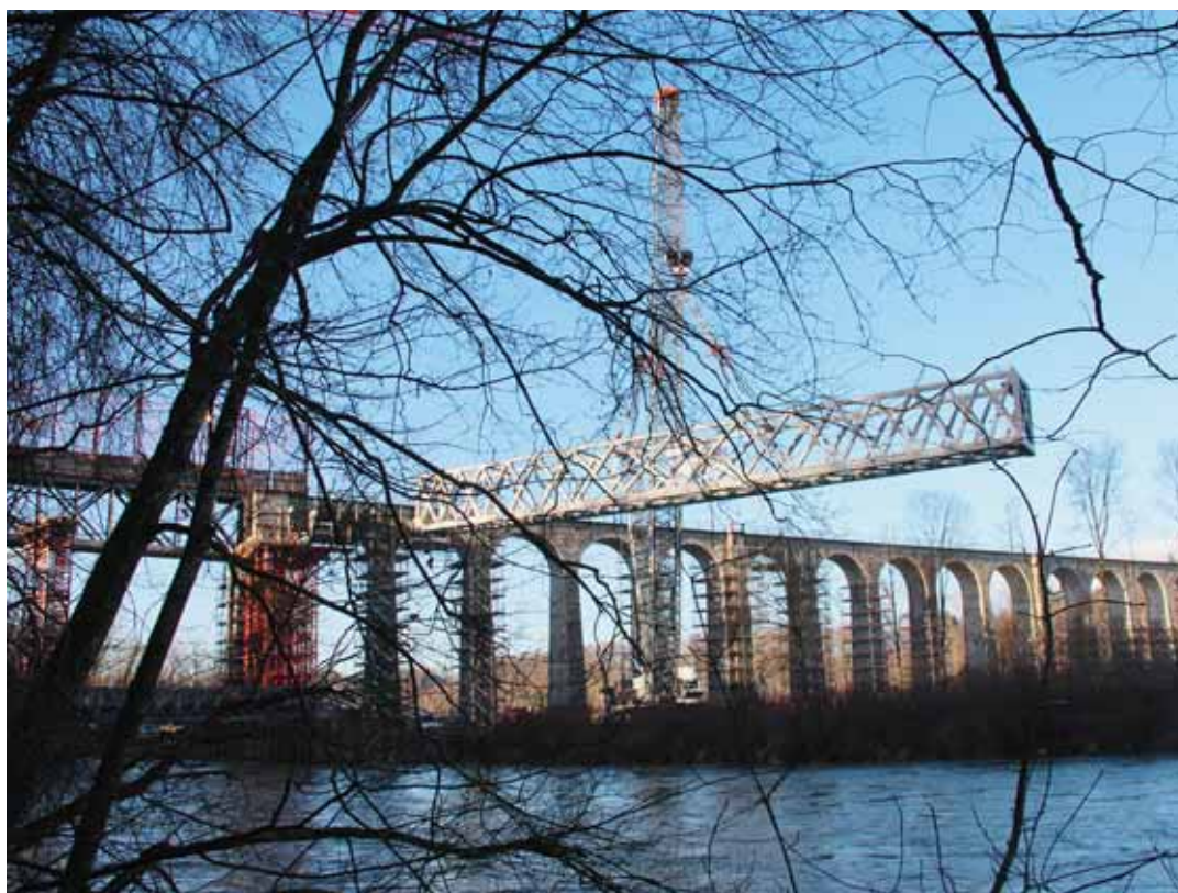
Assainissement et aménagement du viaduc de la Sarine près de Gümmenen par la compagnie BLS. BLS
