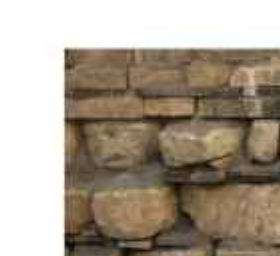
Untergeschoss & Sockel | Bruchsteine
