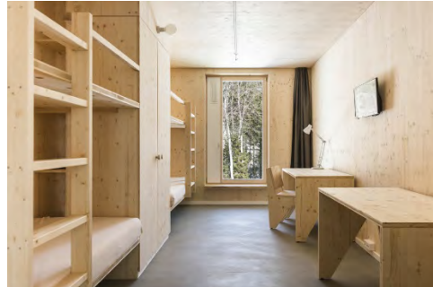
Auch der gesamte Ausbau für das Ausbildungszentrum Zivilschutz wurde mit Mehrschichtplatten entworfen und erstellt. Bild: Micha Riechsteiner
