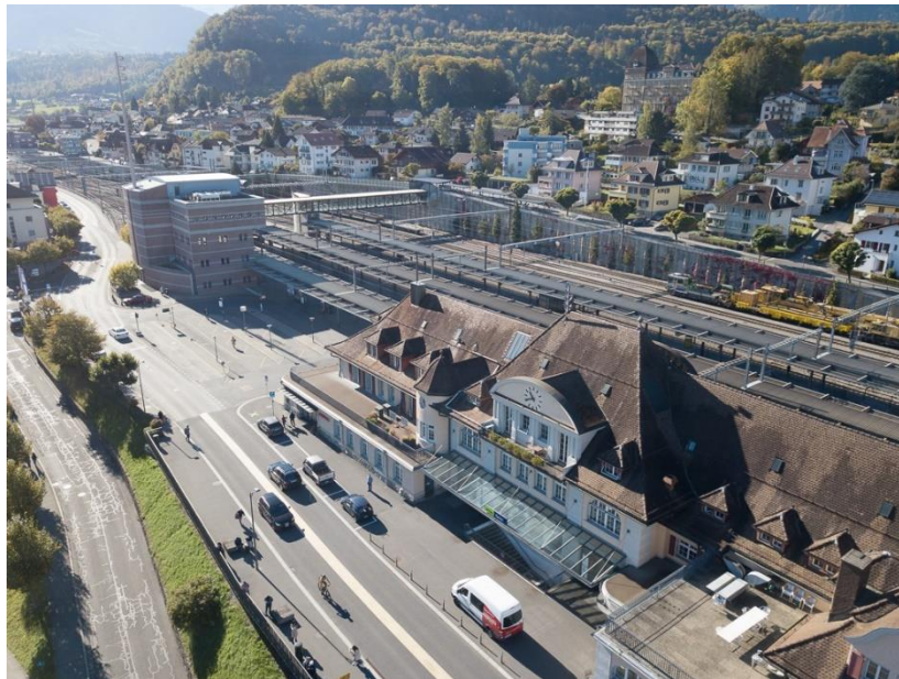
Abb. 1, BLS Bahnhof (vorne) mit Betriebszentrale (hinten) in Spiez, Quelle: Bildarchiv BLS Liegenschaften
