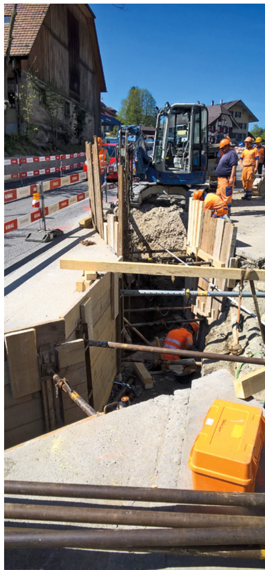
Kanalisationsbaustelle mit gespresstem Graben
