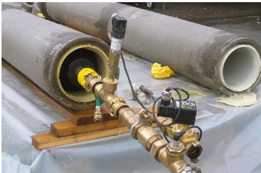
Dichtheitsprüfung mit Luft – Betonrohr mit Schlauchliner
