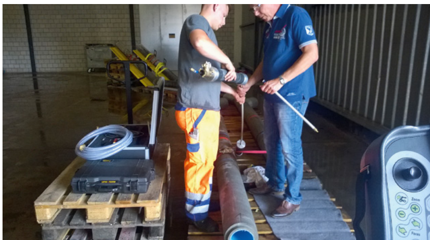
Vorbereiten einer Dichtheitsprüfung mit Packer
