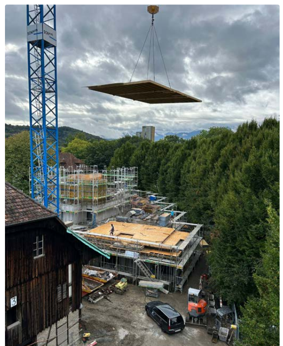
Notdach V.2 Grossformatiges Notdachelement mit OSB
