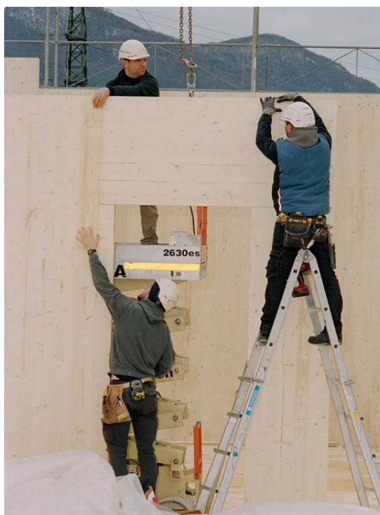
Montage vorgefertigter Holzelemente (Quelle: Veragouth SA)
