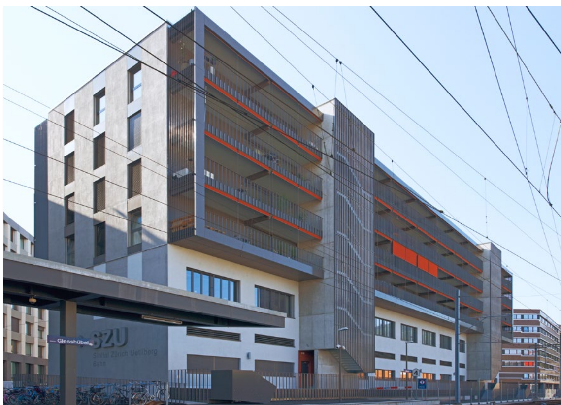
Aufstockung mit vier Geschossen in Holz: das SZU-Gebäude in Zürich.
