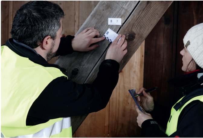
Messung einer Holzspalte an einer Brückenkonstruktion.
