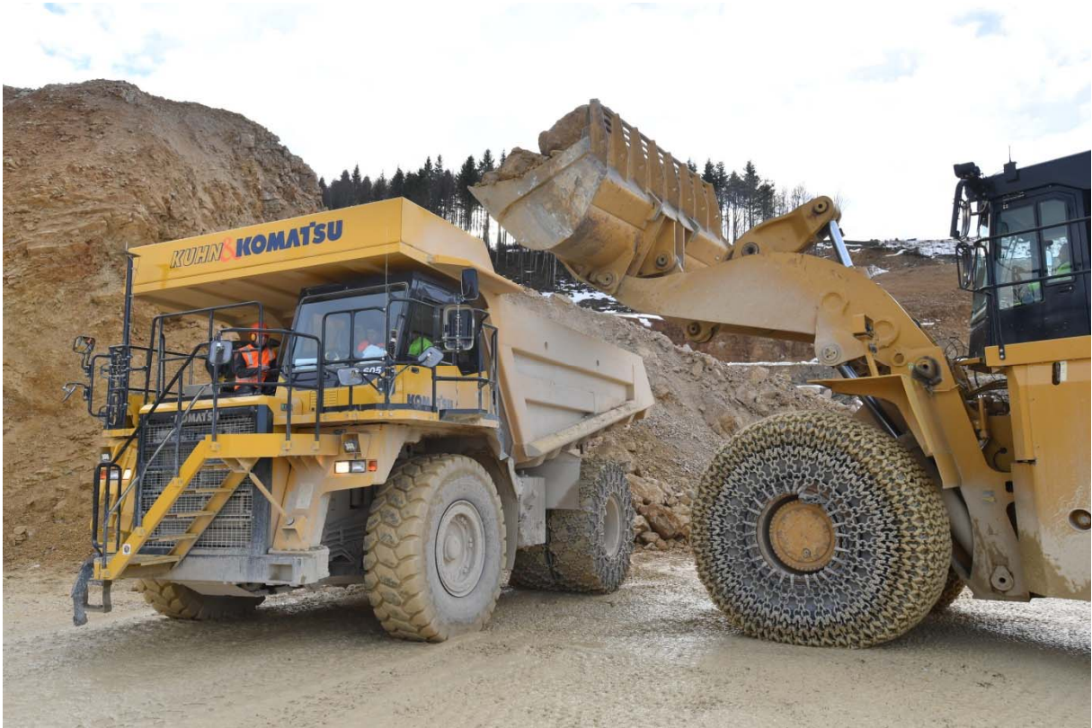
Abbildung 2: Beladung auf dem Berg. Der Muldenkipper Komatsu 605 HD (links im Bild) wird gerade mit einer ca. 700 kWh Lithiumionen-Batterie und der nötigen elektrischen Peripherie ausgestattet.
