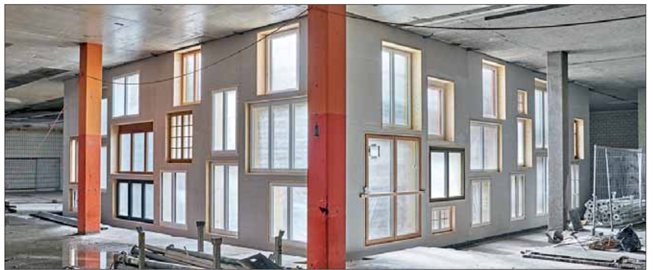
Das Baubüro In Situ verwendet wo immer möglich gebrauchte Bauelemente. Im Bild ein Bau im Lysbüchel-Areal Basel mit gebrauchten Fenstern, die ein zweites Leben erhalten haben. Foto: Baubüro In Situ
