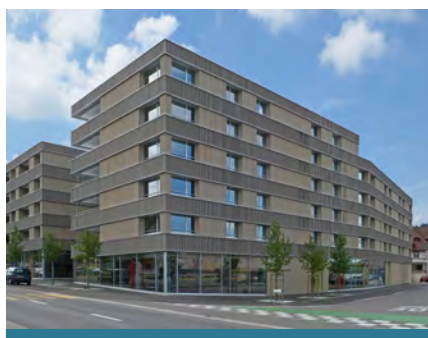
Holzfassade an mehrgeschossiger Überbauung
