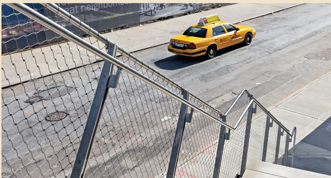
Un projet de Jakob Rope Systems : une passerelle Webnet à Manhattan, New York. Les produits de l'Emmental se distinguent par leur design intemporel, leur longévité et leur sécurité. (Photo: mad)
