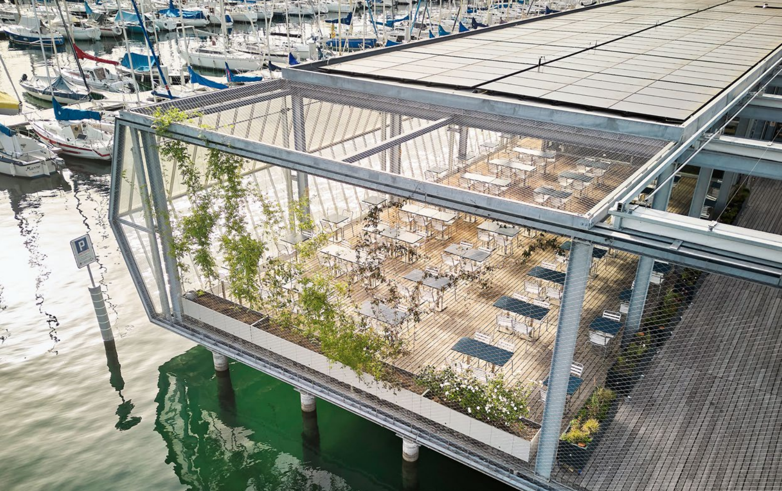
Ein Projekt von Jakob Rope Systems: Edelstahlnetze und Seile umhüllen zwei Seebauten in Genf. (Foto: zVg)
